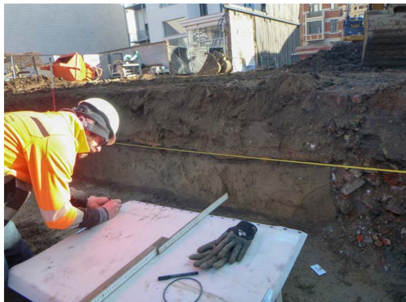
▲ De bodemopbouw van de site wordt zorgvuldig in kaart gebracht © Vlaams Erfgoed Centrum
