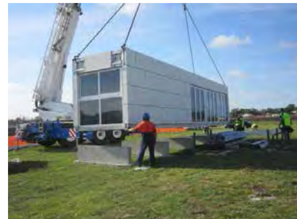
Houtskeletmodule (Vandewalle - Jonckheereprojects)
