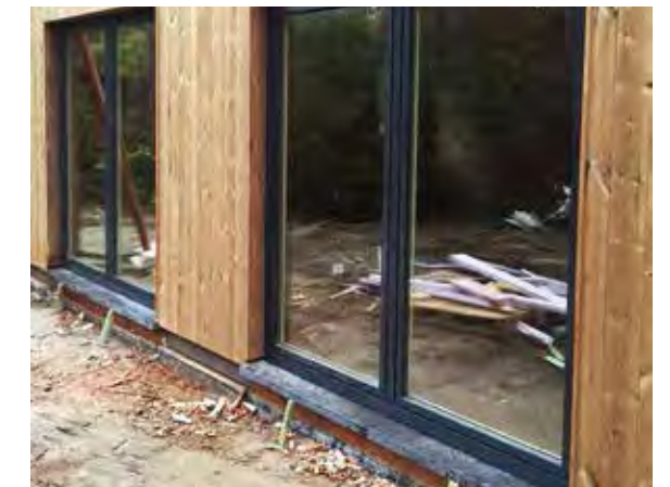
Staalstructuur + afwerking in Thermowood (Dollez)
