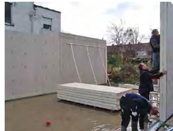
Zelfdragende isolerende sandwichpanelen Ecohomepanel (Van de Steene - Luvatri)
