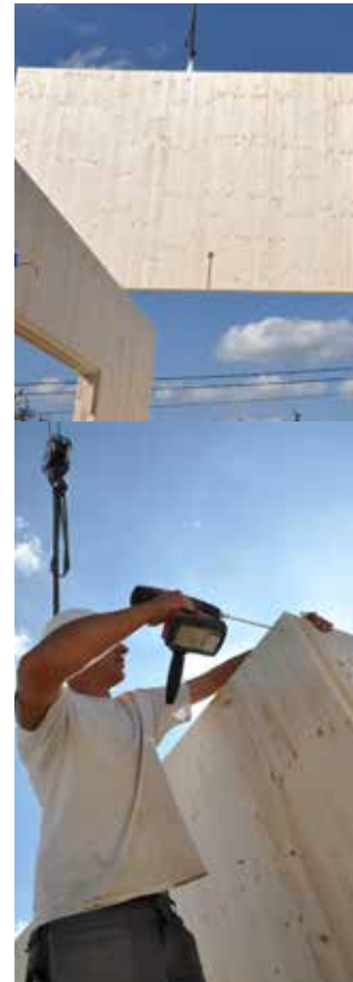
In-situ constructie van geprefabriceerde CLT-panelen (Newcraft)
