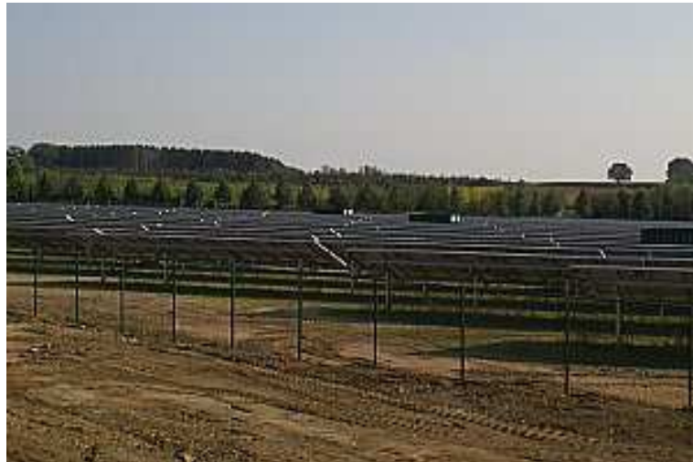
Figuur 6: Zonnepark op voormalig terrein hinderlijke industrie in Schaffen
